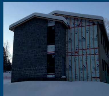
Cage d'escalier (droite) en bloc architectural
