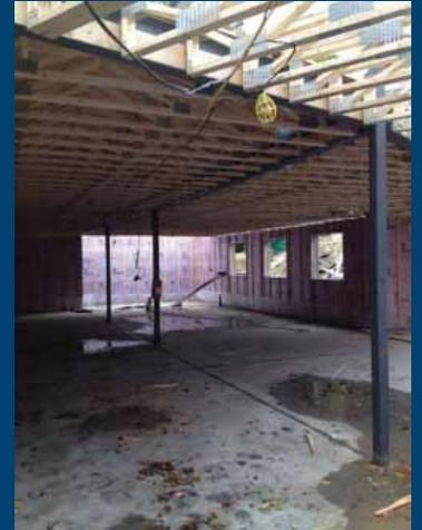
Sous-sol avec poutrelles du RDC et une partie du contre-plaqué installé
